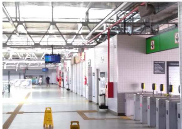
Figura 3-32 – Mezanino da estação Deodoro
