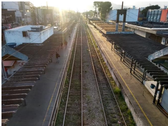
Figura 3-29 – Plataforma da estação Campo Grande
